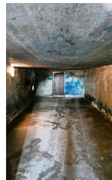
Majdanek: Gaskammer 2 mit Rohr für Kohlenmonoxid und Spuren des Blausäureeinsatzes
