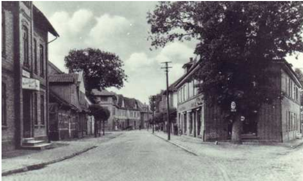
Bild Lange Straße, die Nummer 32 ist das Fachwerkhaus auf der linken Seite
